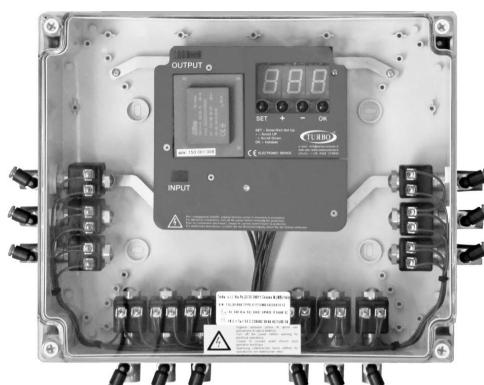
Секвенсер призначений для керування (за таймером) імпульсними клапанами, які керують, у свою чергу, акумульованими аспіраційними блоками. Він має 2 вихідних контактних реле і 2 цифрові вхідні контакти.
